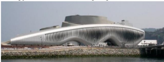
б) трансформація фасаду, що складається з рухомих, пластин, що розкриваються
