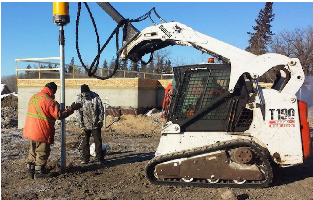
Рисунок 2.33 – Установка для загвинчування палей
