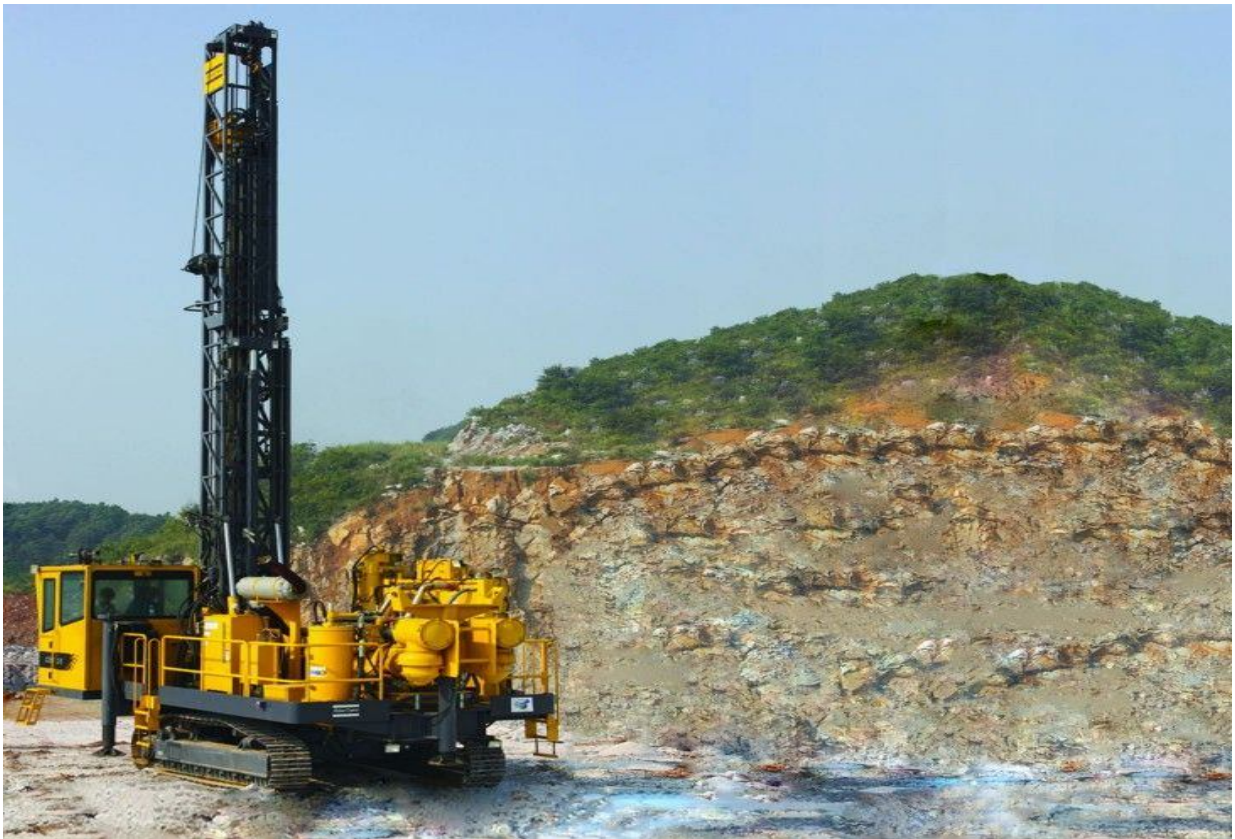
Рисунок 3.18 – Буровая установка Atlas Copco
