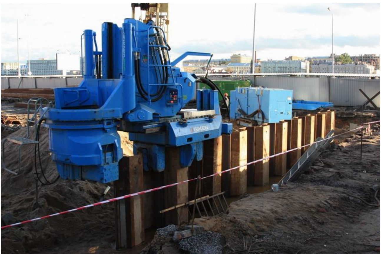
Рисунок 1.16 – Установки для вдавлювання шпунта системи Still Worker: а – схема переміщення по шпунтовому ряду; б – зовнішній вигляд установок; 1 – анкерні затискні блоки; 2 – анкерні шпунтини; 3 – гідроциліндр горизонтального переміщення; 4 – занурювальний шпунт; 5 – затискні блоки вдавлюваної головки; 6 – гідроциліндри вдавлювання
