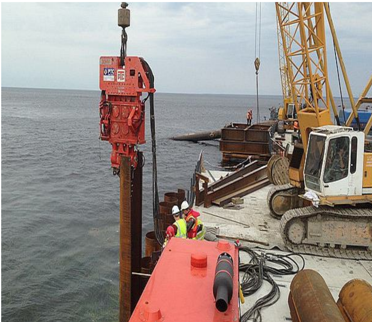
Рисунок 1.9 – Вібросанурення шпунтів
