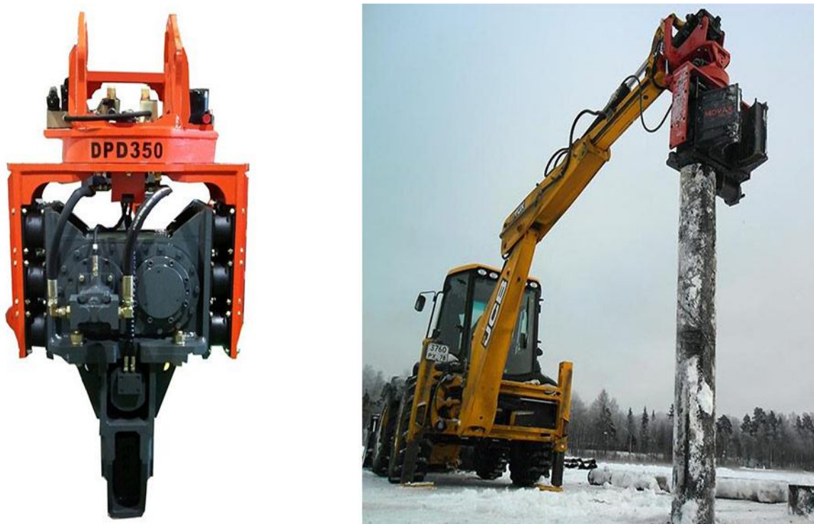
Рисунок 3.29 – Віброзанурювач бетонних паль
