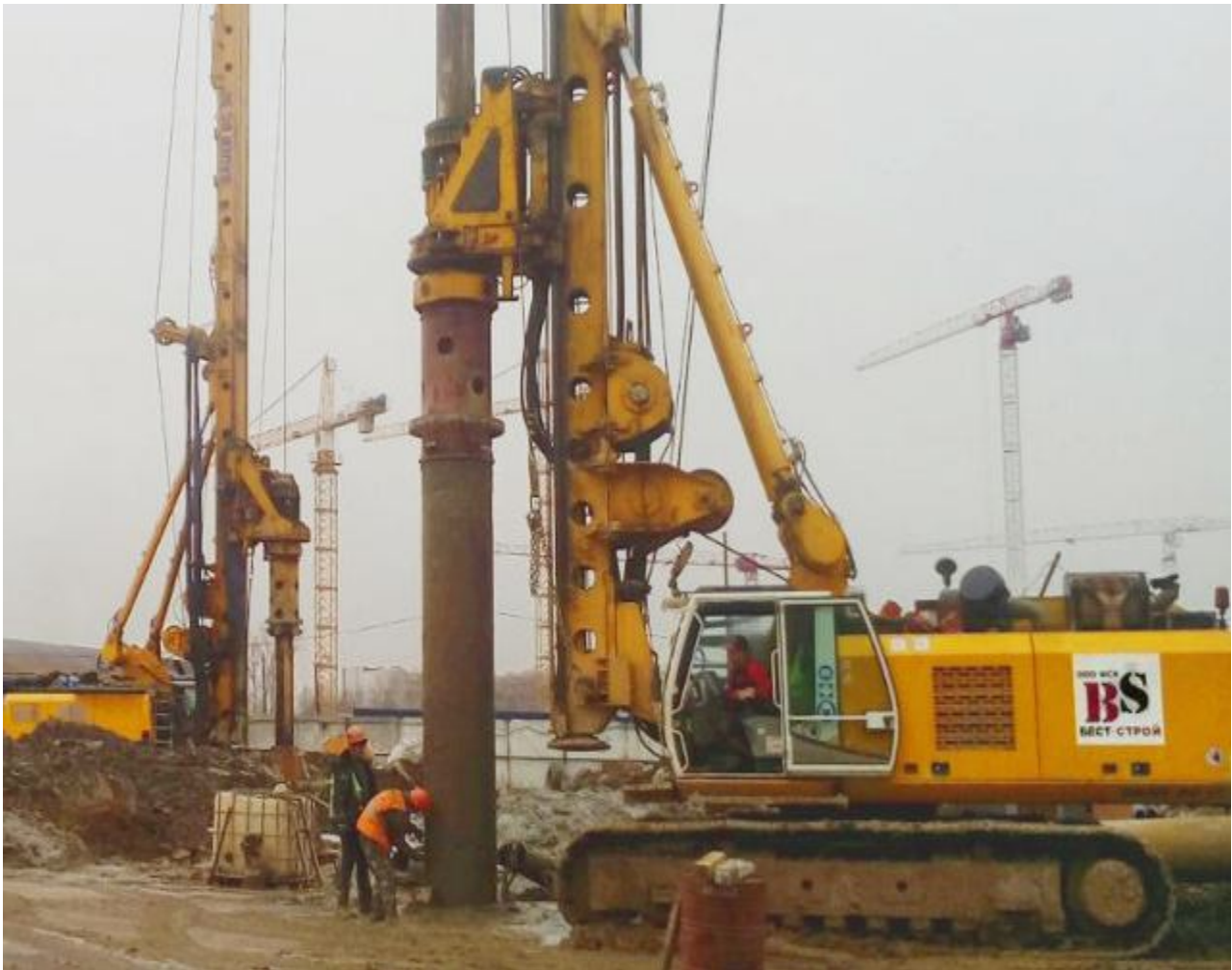
Рисунок 3.6 – Установка для влаштування паль під захистом обсадних труб
