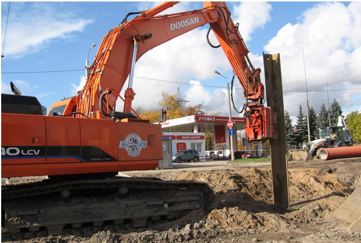
Рисунок 1.14 – Екскаватор, оснащений віброзанурювачем
