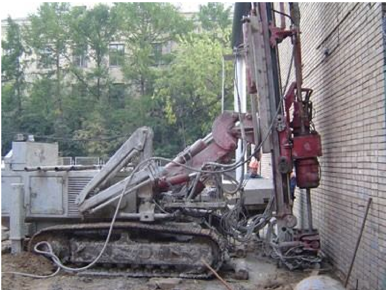
Рисунок 3.24 – Пересувна установка для влаштування буроін'єкційних палей
