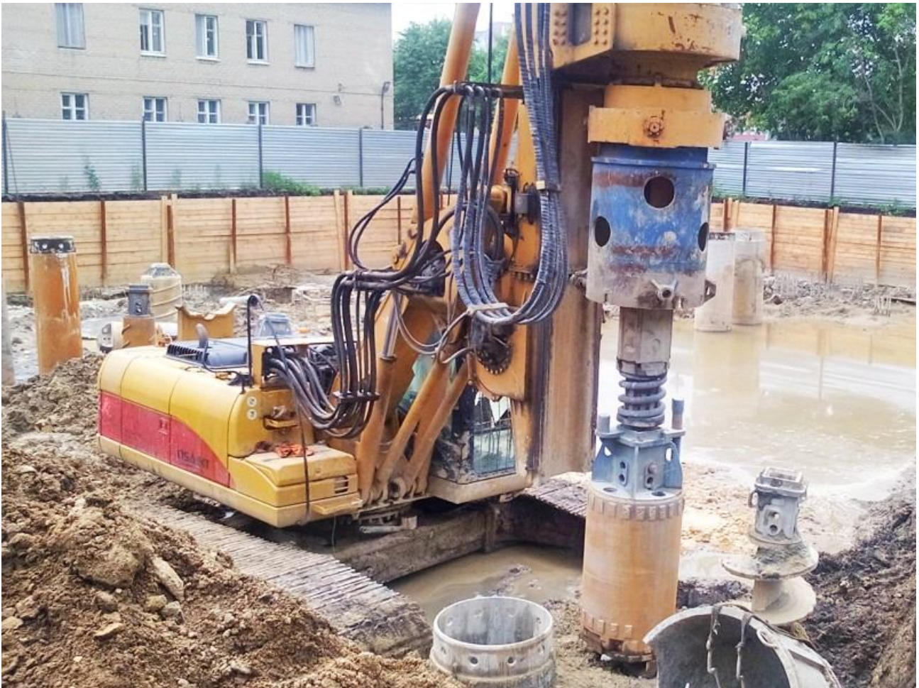
Рисунок 3.1 – Улаштування фундаментів на бурових палях
