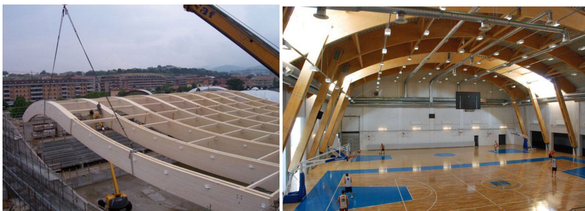
Рисунок 6.10 – Застосування клеєної деревини для великопрольотних клеєних дерев'яних конструкцій
