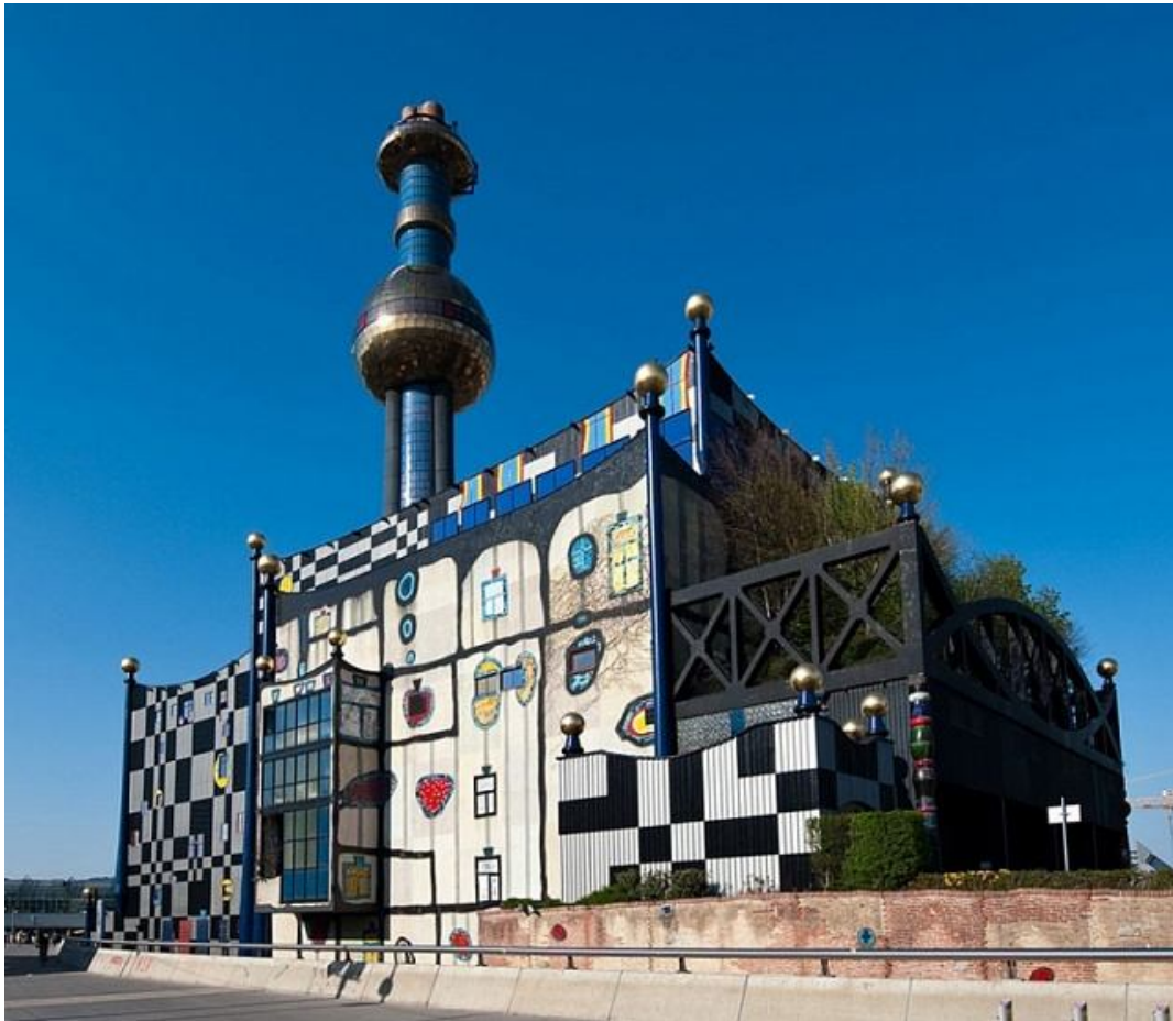
Рисунок 9 – Сміттєспалювальний завод Шпіттелау
