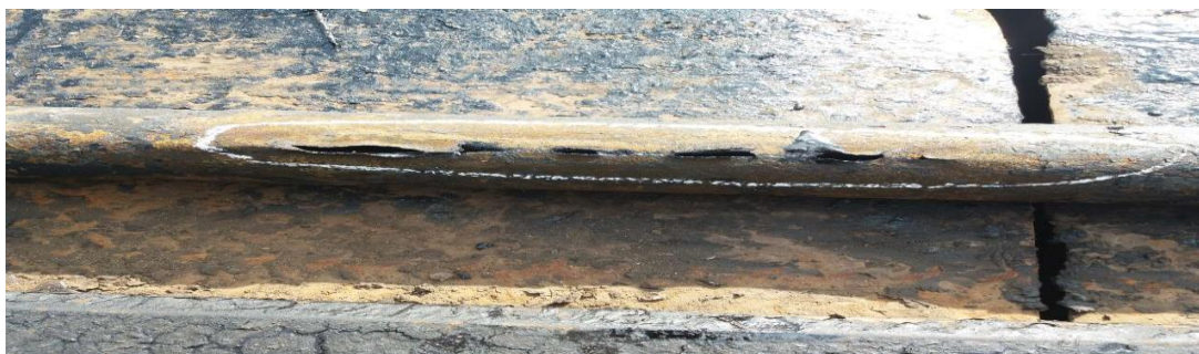
Рис.1. Загальний вигляд корозійного руйнування обсадної труби із сталі K55 на одному з родовищ Іраку. Термін експлуатації 1-2 роки.
