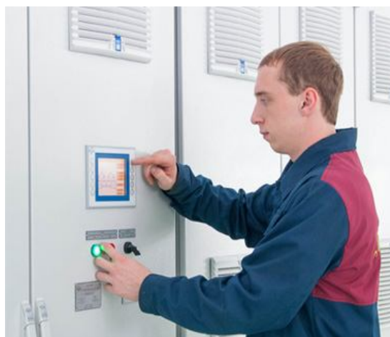
Рисунок 4.7 – Промисловий контролер типу РР65 з функцією візуалізації
