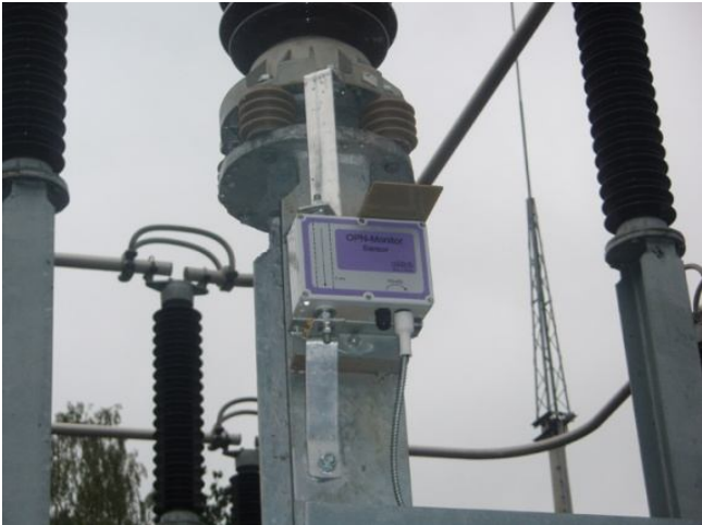
Рисунок 3.6 – Автоматизована система типу ОПН-Монітор
