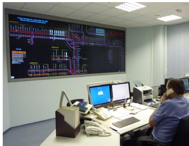
Рисунок 3.3 – Автоматизоване робоче місце енергодиспетчера на центральному диспетчерському пункті залізниці
