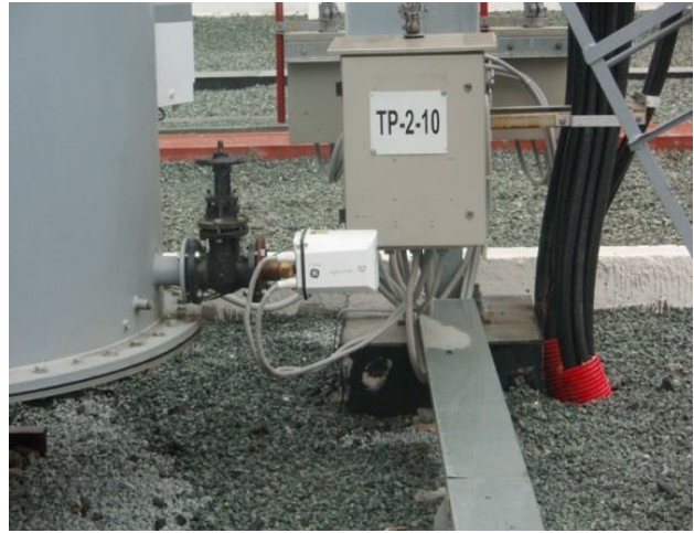
Рисунок 3.7 – Прилад HYDRAN M2 (General Electric) для визначення вмісту газів в трансформаторному маслі
