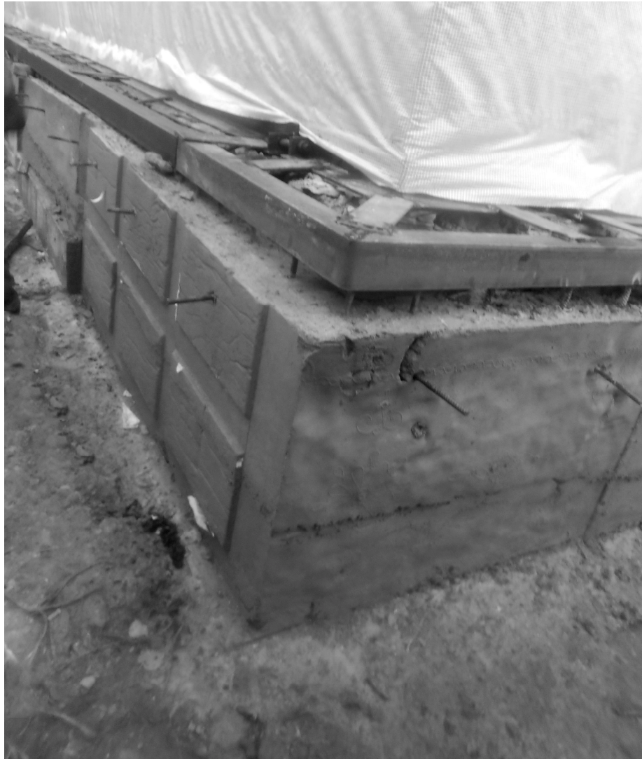
Рисунок 6.9 – Приклад реконструкції та посилення фундаменту (разопалубка конструкції)
