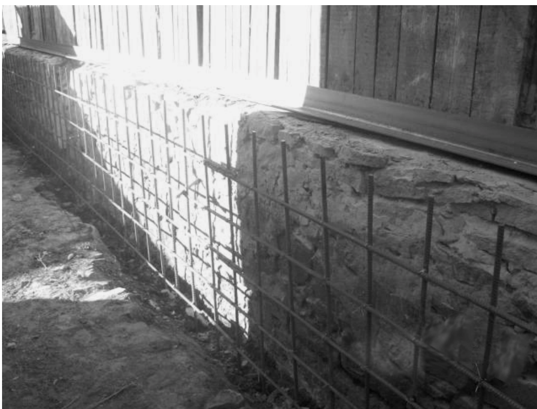
Рисунок 6.6 – Приклад реконструкції та посилення фундаменту (установка арматурних стрижнів у пробурені шпури)
