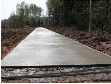
Рисунок 31 – Укладання і вирівнювання поверхні цементобетонного покриття.
