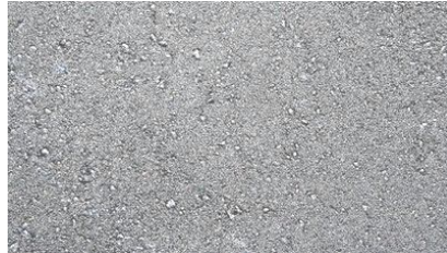
Рисунок 27 – Загальний вигляд асфальтобетонної поверхні
