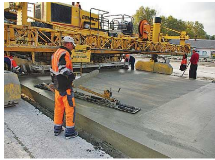
Рисунок 31 – Укладання і вирівнювання поверхні цементобетонного покриття.
