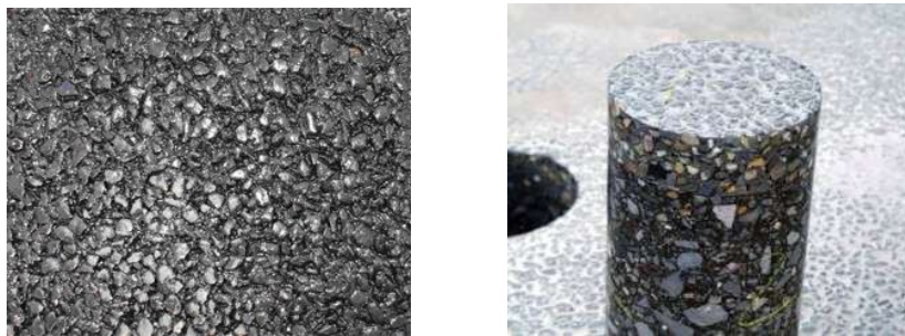
Рисунок 29 – Зовнішній вигляд поверхні з литого асфальтобетону та керну, що вирізаний з готового покриття
