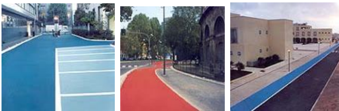
Рисунок 52 – Покриття з декоративного бетону
