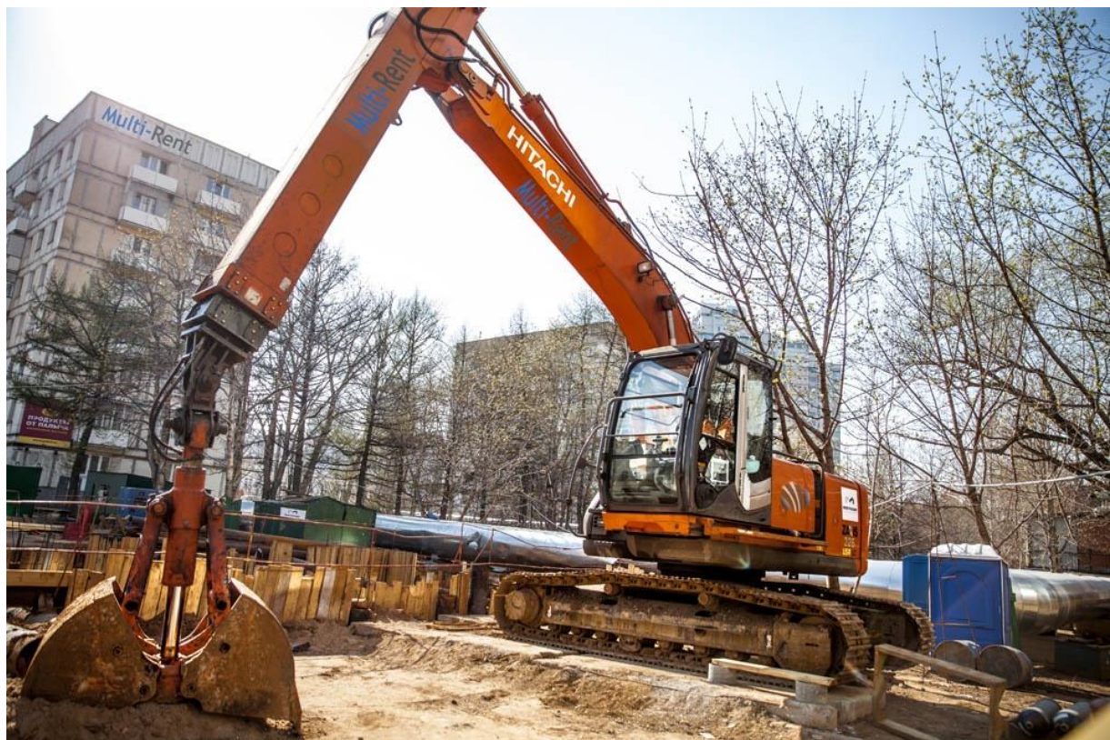
Рисунок 4.46 – Екскатор з обладнанням «грейфер»
