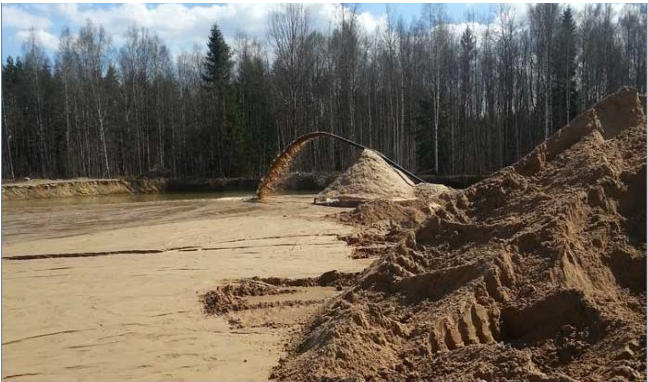
Рисунок 5.9 – Безестакадний спосіб намівання ґрунту
