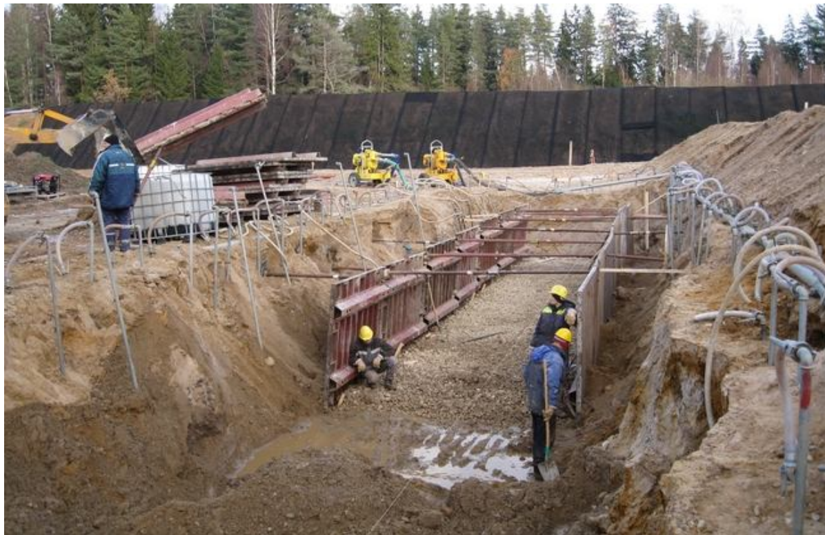
Рисунок 3.3 – Голкофільтровий спосіб зниження рівня ґрунтових вод
