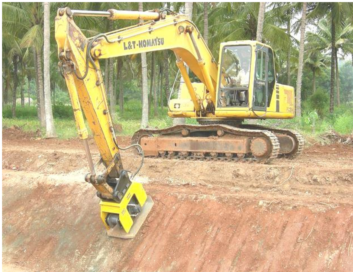
Рисунок 3.19 – Використання навісних трамбувальних плит для ущільнення ґрунту
