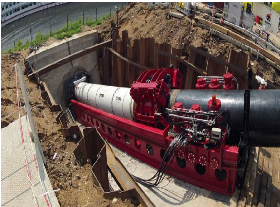
Рисунок 5.28– Сучасний електронний комплекс управління робіт мікротонелювання
