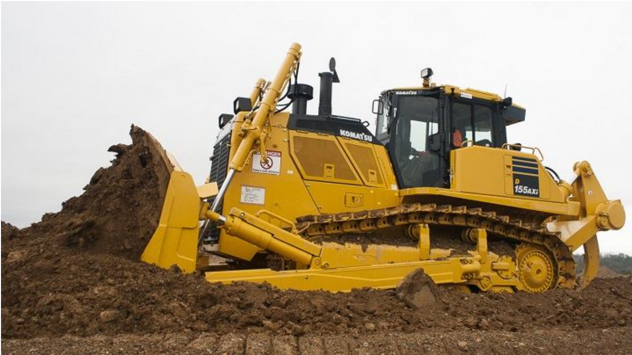
Рисунок 1.1 – Розроблення ґрунту бульдозером
