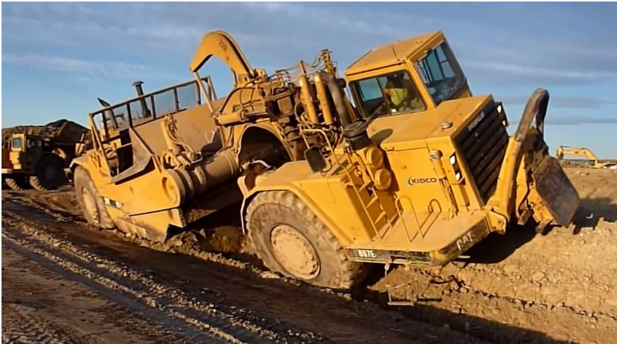
4.18 – Планування за допомогою скрепера будівельного майданчика на похилій ділянці
