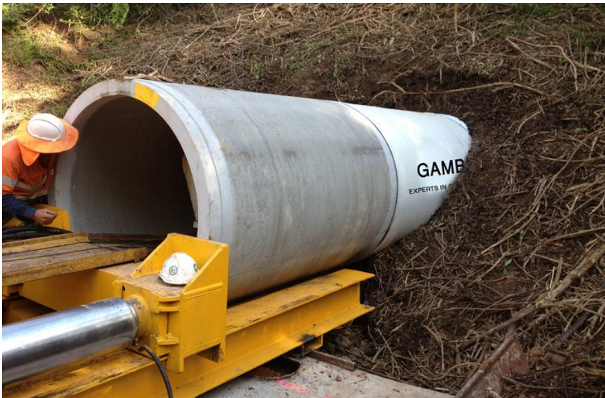
Рисунок 5.22 – Прокладання труб методом статичного продавлювання
