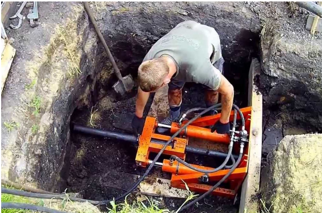
Рисунок 5.20 – Проколювання ґрунту
