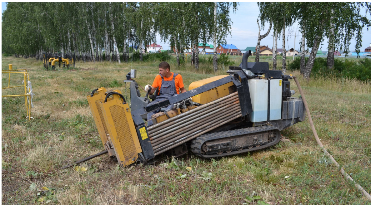
Рисунок 5.24 – Горизонтально-похиле буріння
