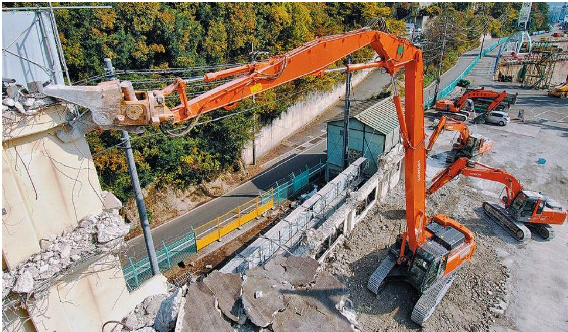
Рисунок 2.3 – Знесення багатоповерхового будинку за допомогою гідрножиць і подовженої стріли
