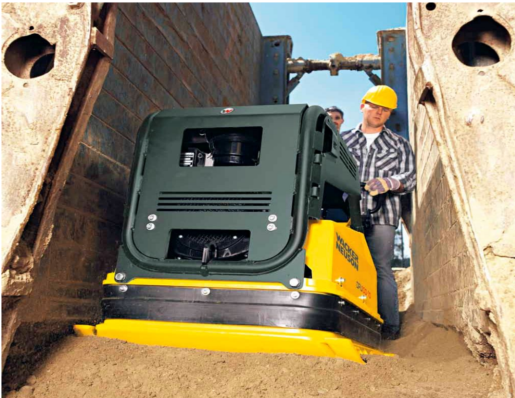
Рисунок 3.17 – Використання віброплити для ущільнення ґрунту
