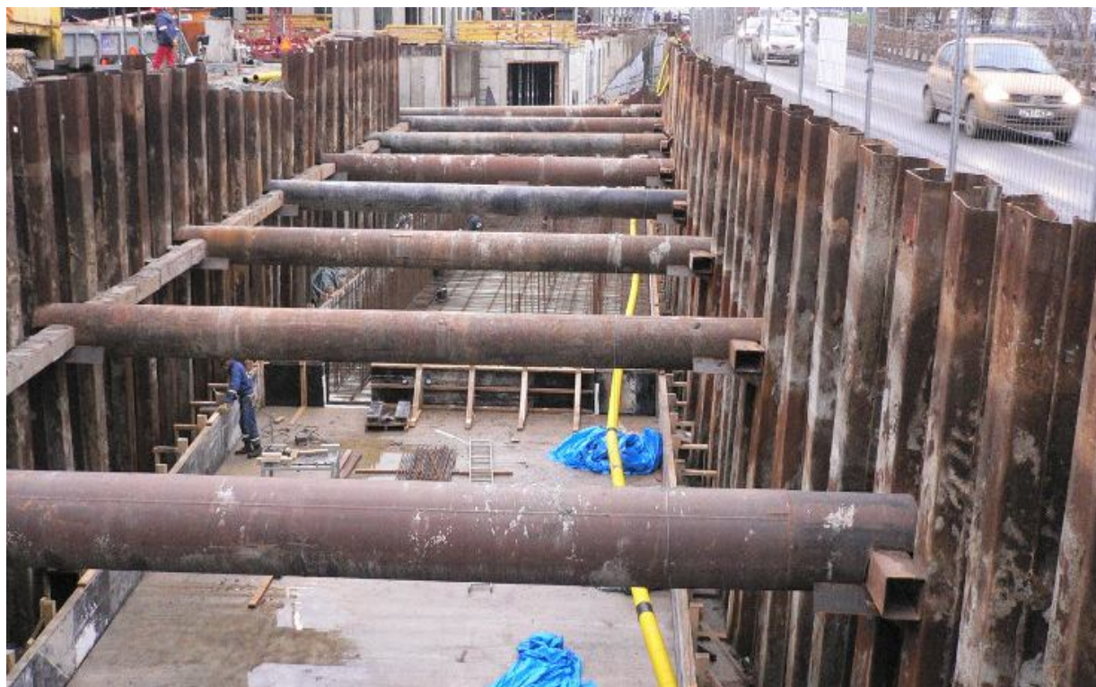
Рисунок 3.7 – Шпунтово-розпірне обгородження котловану
