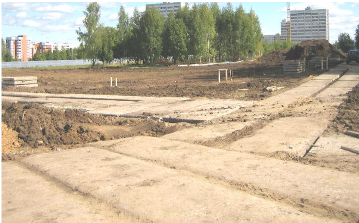
Рисунок 2.2 – Влаштування тимчасових доріг
