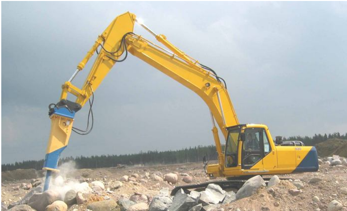
Рисунок 2.11 – Прибирання валунів і каменів із території об'єкта будівництва
