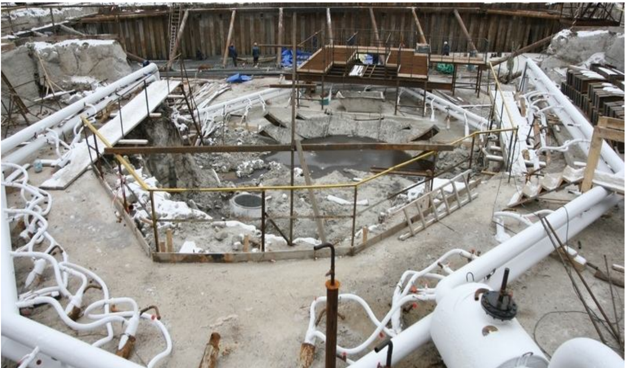
Рисунок 3.8 – Штучне заморожування ґрунтів
