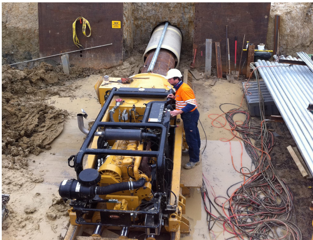
Рисунок 5.25 – Горизонтальне шнекове буріння
