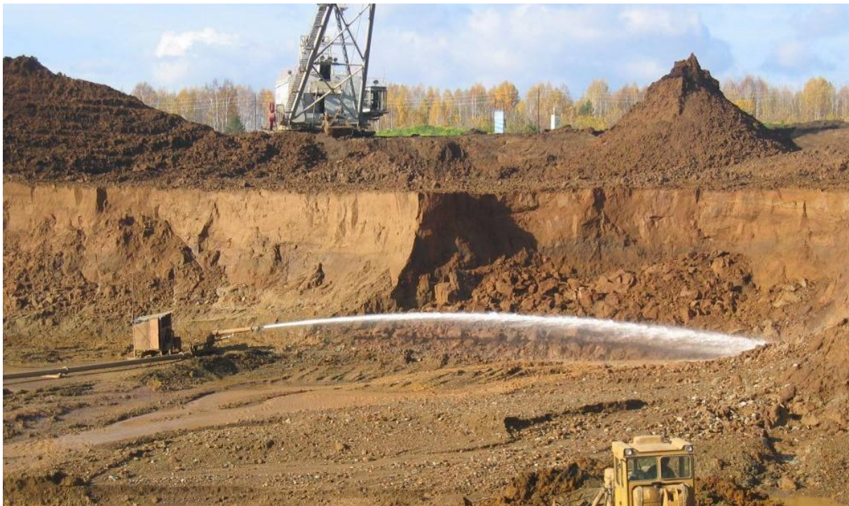
Рисунок 5.1 – Гідромеханічний спосіб виконання земляних робіт
