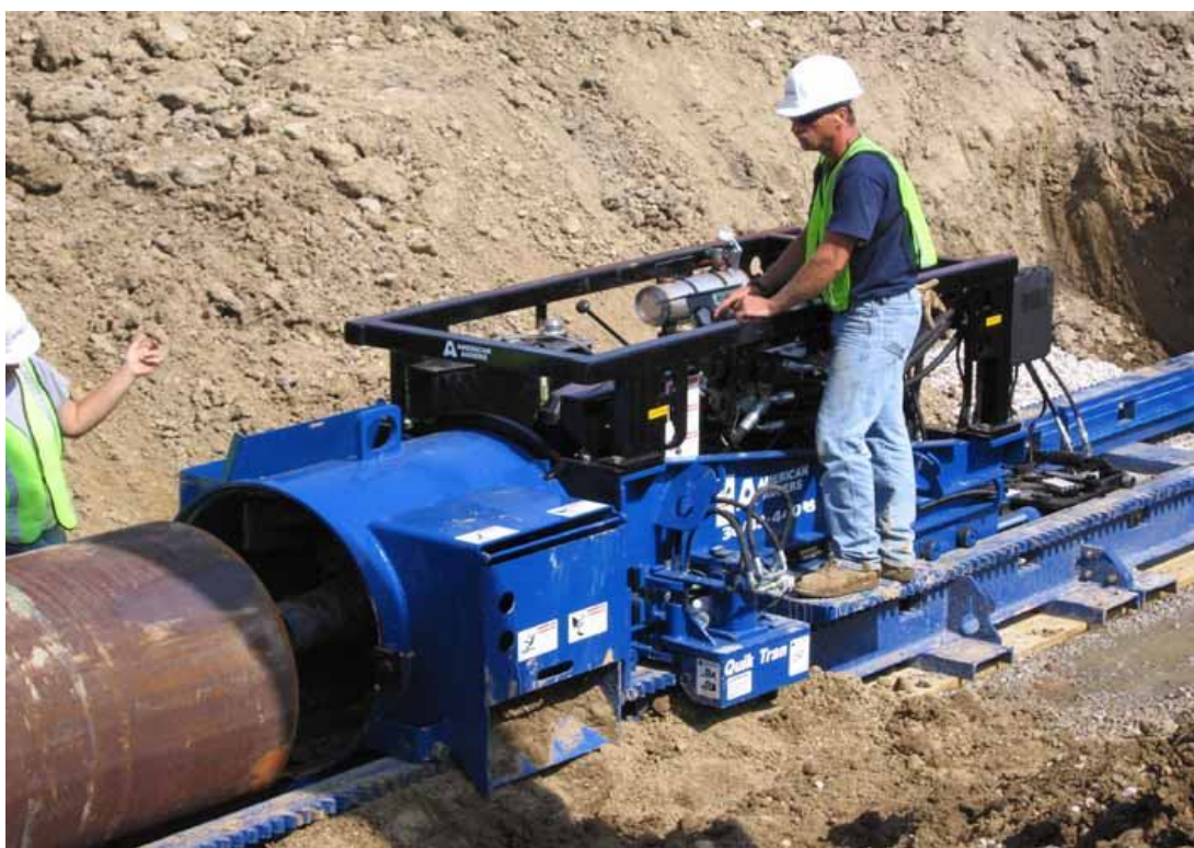
Рисунок 5.23 – Горизонтальне буріння ґрунту
