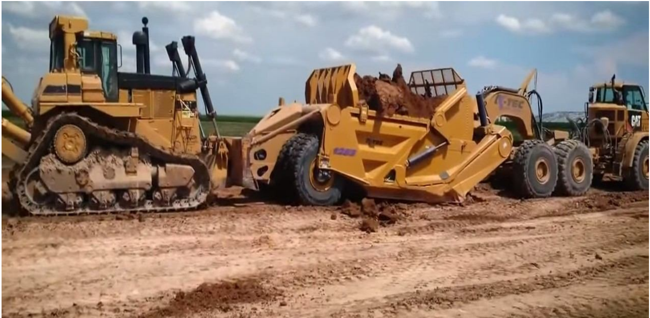
Рисунок 4.1 – Комплексна механізація виконання земляних робіт
