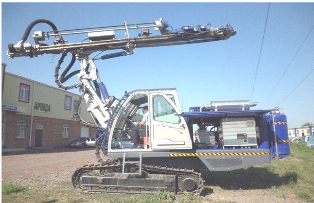
Рисунок 5.16 – Гідравлічна бурова установка
