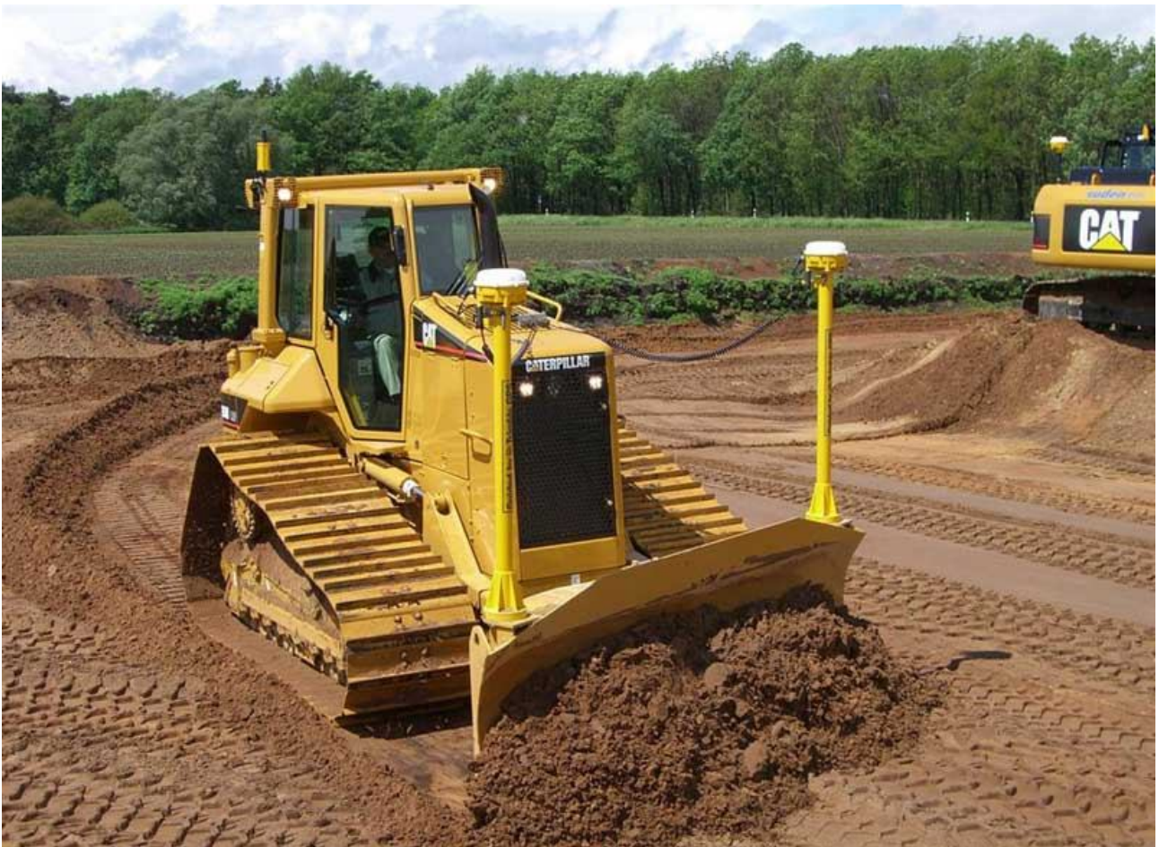
Рисунок 4.12 – Переміщення ґрунту бульдозером
