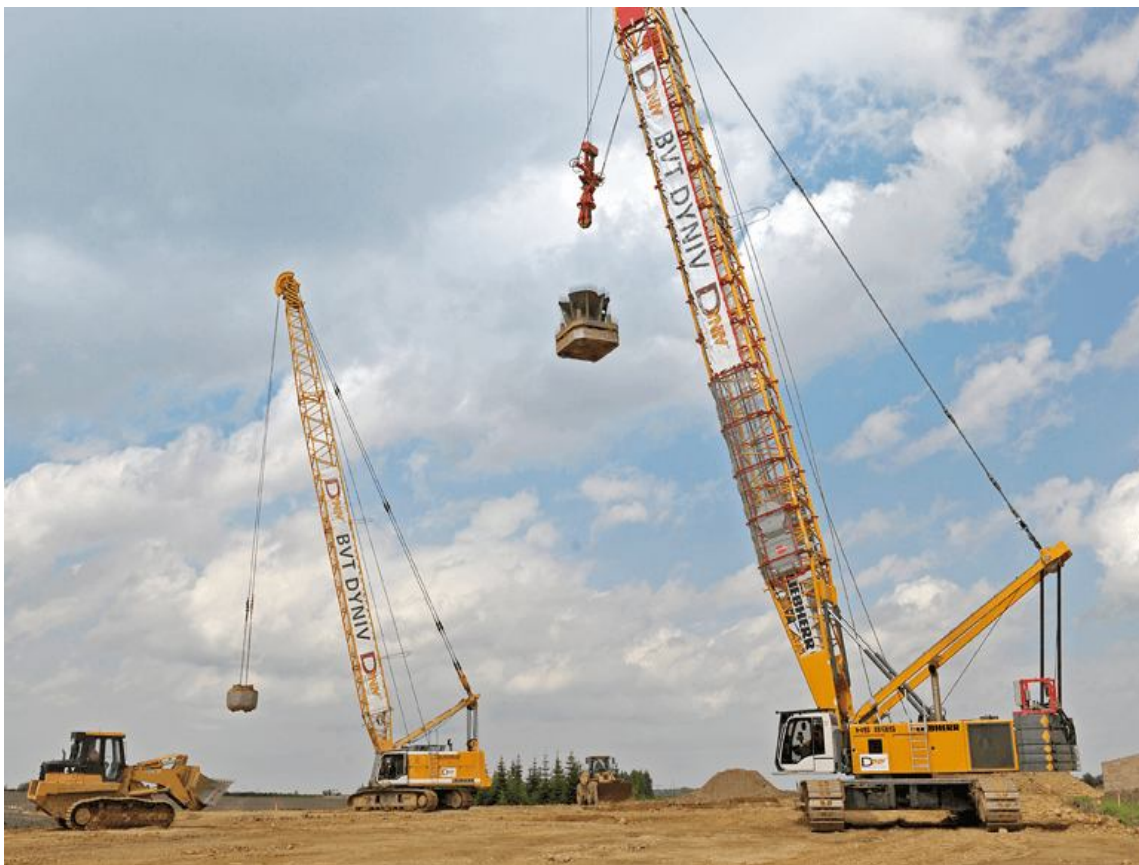
Рисунок 3.18 – Використання підвісної (до крана) віброплити для ущільнення ґрунту
