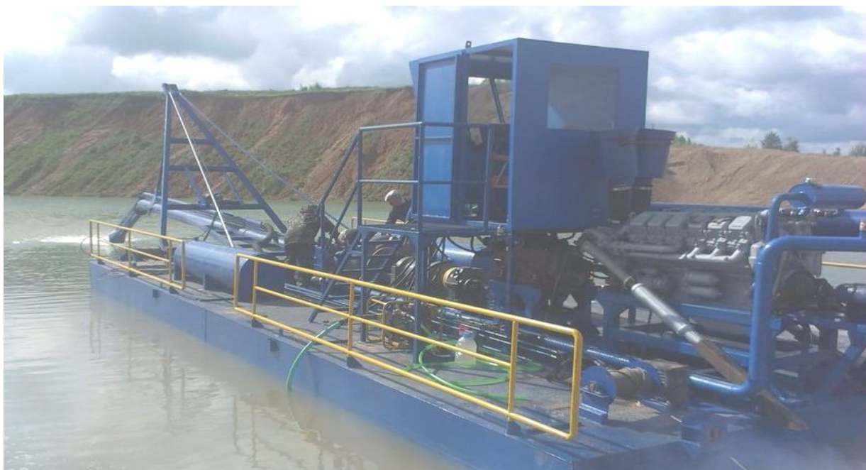
Рисунок 5.8 – Транспортування ґрунту землесосними снарядами
