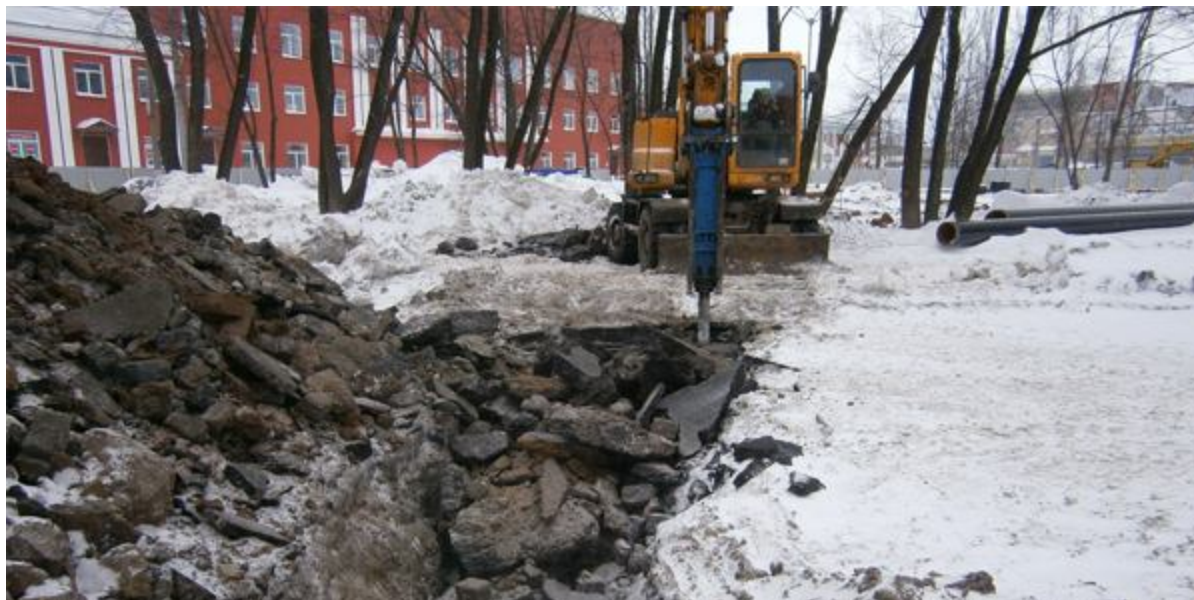
Рисунок 6.8 – Розроблення ґрунту в зимовий період за допомогою іклів
