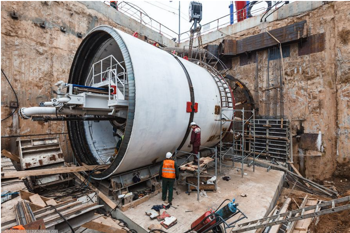
Рисунок 5.27 – Технологія щитового проходження ґрунту
