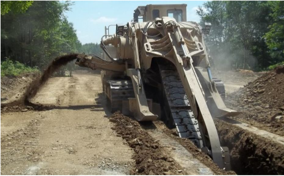
Рисунок 1.4 – Виймання ґрунту для прокладення підземних комунікацій
