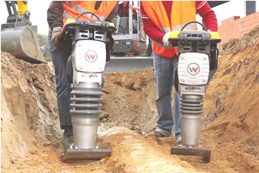
Рисунок 3.20 – Використання трамбівок із ручним керуванням
