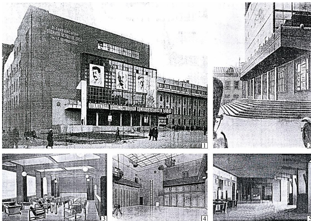
Рисунок 1 – Будинок Червоної армії та флоту. Харків, 1932 р.: 1. Загальний вигляд.
