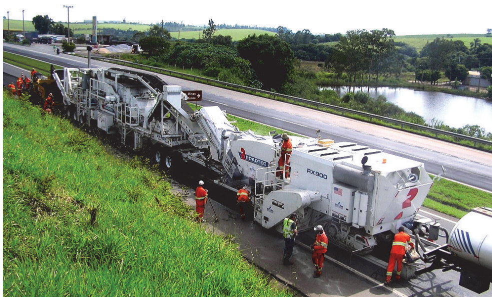
Рис. 4. Механізований комплекс по переробці й укладанню асфальту
