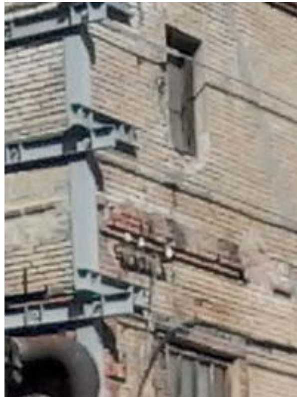
Рис.5. Установка стальных бандажів на будівлі котельні
