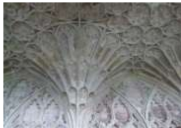
Рисунок 2 – Глостерський собор, Англія. Приклад нервюра, що виконують функцію декору.
