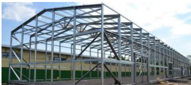
Рисунок 2 - Каркас промислової будівлі
