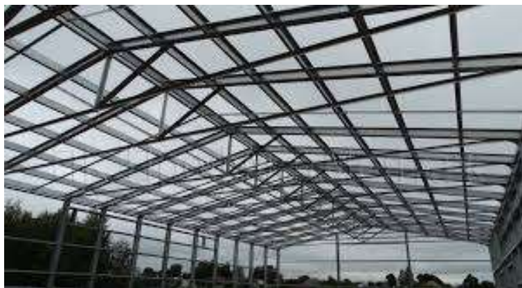
Рисунок 1 - Каркас торгового павільйону
