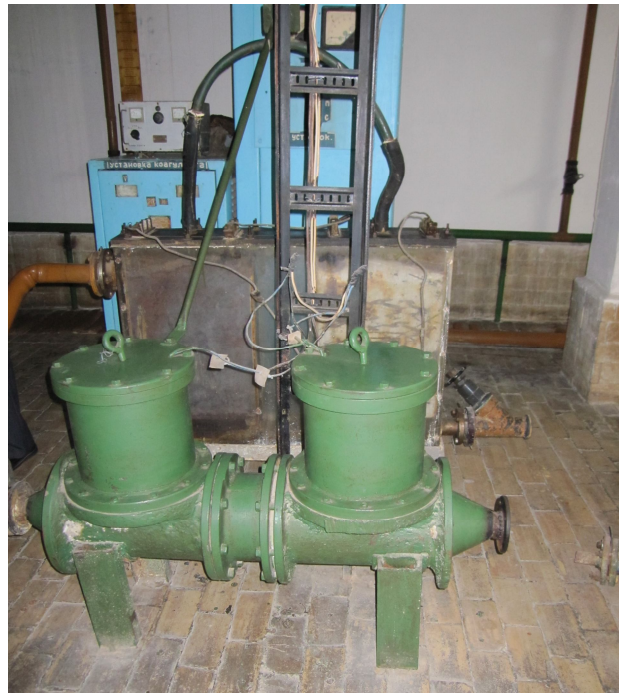
Рисунок 2.8 – Общий вид производственной установки для активации раствора коагулянта сульфата алюминия
