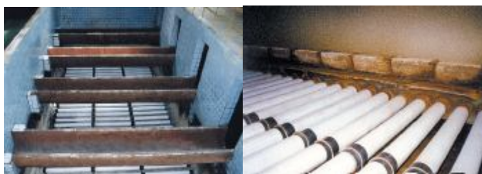
Рисунок 5.1 – Применение трубофильтров в дренажно-распределительной системе скорых фильтров
