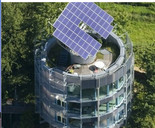
Heliotrope, м. Фрейбург, Німеччина Будівля обертається за сонцем; архітектурно-планувальні засоби енергозбереження – сонячні вікна; технічні засоби – сонячні батареї: виробляє у 5 разів більше енергії, ніж використовує; оснащена системами збору дощової води і водоочищення.
