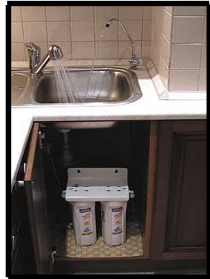
Рис.1 – Установка фильтра под мойкой
