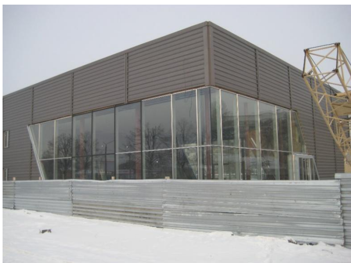
Рис.1. – Строительно-монтажные работы автосалона
