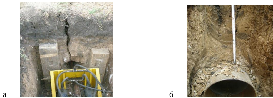
Рисунок 1 - Фрагменты экспериментального определения влияния диаметра скважины на разрушение дневной поверхности грунта
