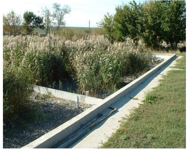
Рис. 3. Локальні очисні споруди м'ясокомбінату з біоплато доочистки потужністю 400 м 3 на добу
