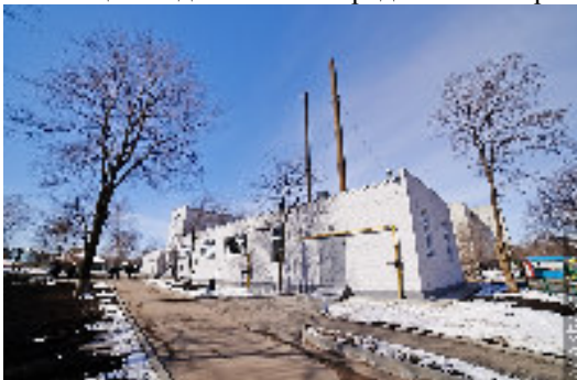
Рис. 1. Общий вид котельной по ул. Шевченко, 301а
