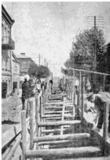
Прокладка канализационных труб
