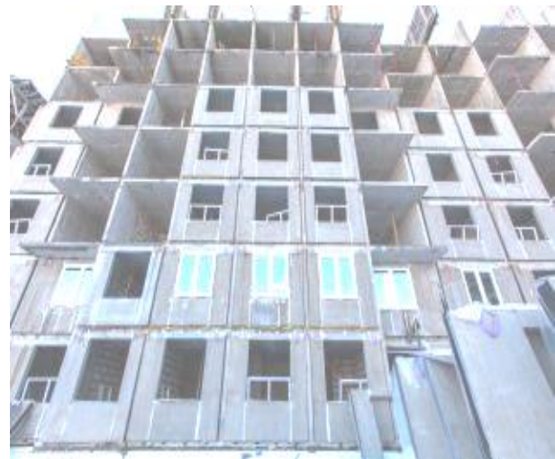
Рис. 1. Строительство жилого дома с монолитным каркасом и ограждающими конструкциями из панелей на деревянном каркасе в г. Санкт-Петербурге (Россия)
