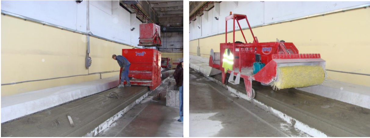
Рис. 12. Линия по производству плит на заводе по изготовлению железобетонных конструкций в городе Сумы
