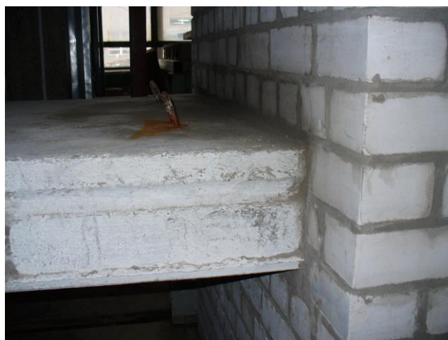
Рис. 9. Защемление плиты на опоре
