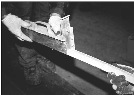
Рис. 3 – Нанесення епоксидного клею на стрічку за допомогою каретки
