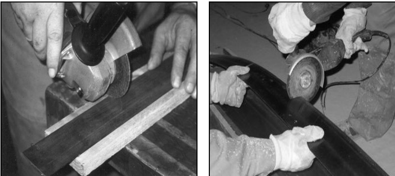
Рис. 2 – Нарізка композитної стрічки на елементи необхідної довжини
