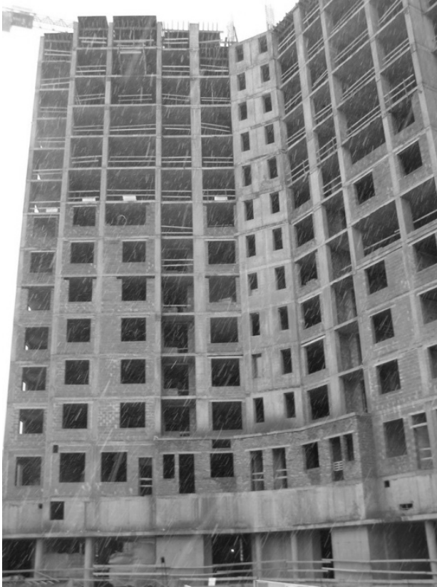
Рис. 1 – Вигляд будівлі під час обстеження
