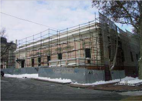
Рис. 4 – Фрагмент начала проведения ремонтно-восстановительных работ
