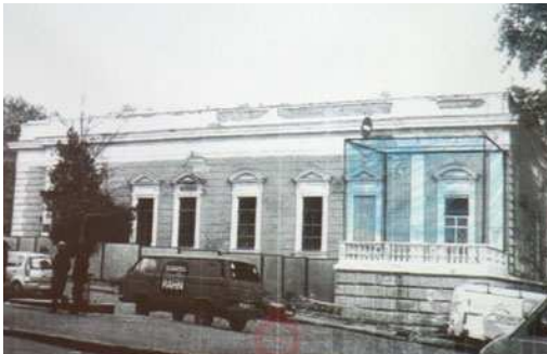
Рис. 2 – Фрагмент фасада здания со стороны двора
