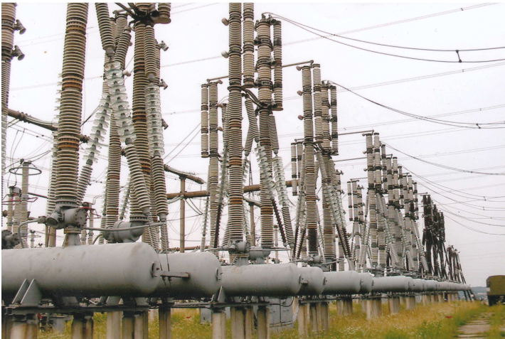
Рис. 15.2 – Загальний вигляд повітряного вимикача ВВ-330
