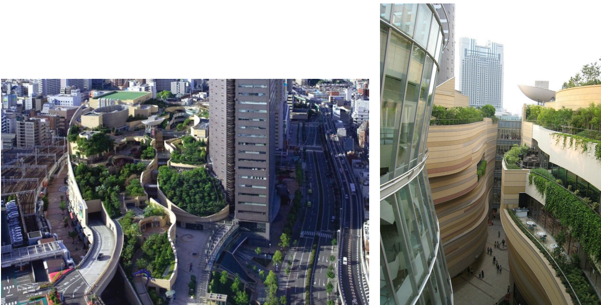
Рис. 1.37 – Паркові Вежі (Parks Tower), терасові сади, Намбу Парки (Namba Parks) в Осаці
