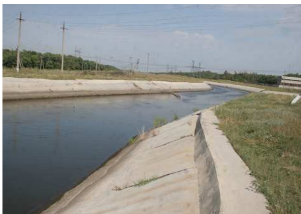
Рис. 15.4 – Канал Сіверський Донець - Донбас на ділянці з облицюванням залізобетонними плитами
