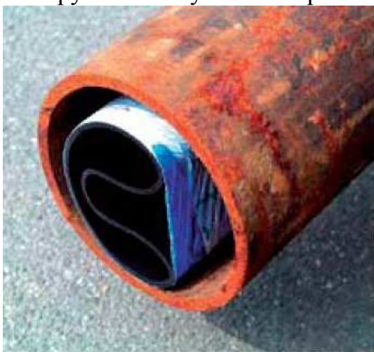
Рис. 18.9 - Труба «Compact SlimLiner», розміщена у відновлювальному трубопроводі
