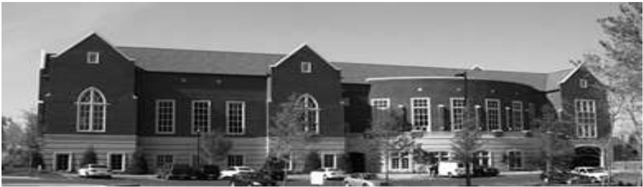
Рис. 57 - Dozier center for the performing arts. Джорджия. США. Фасад
