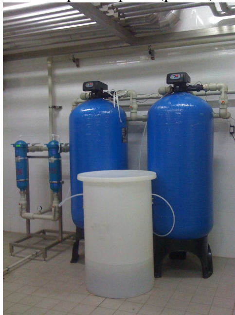
Рис. 2 - Схема блоку доочищення води
