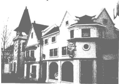
Рис. 15 - Будівля на основі металевого каркасу. Великобританія, Діснейленд, павільон «Лего», Технологія «Драйвит»
