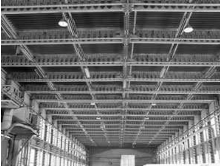
Конструктивне рішення каркасної промислової будівлі
