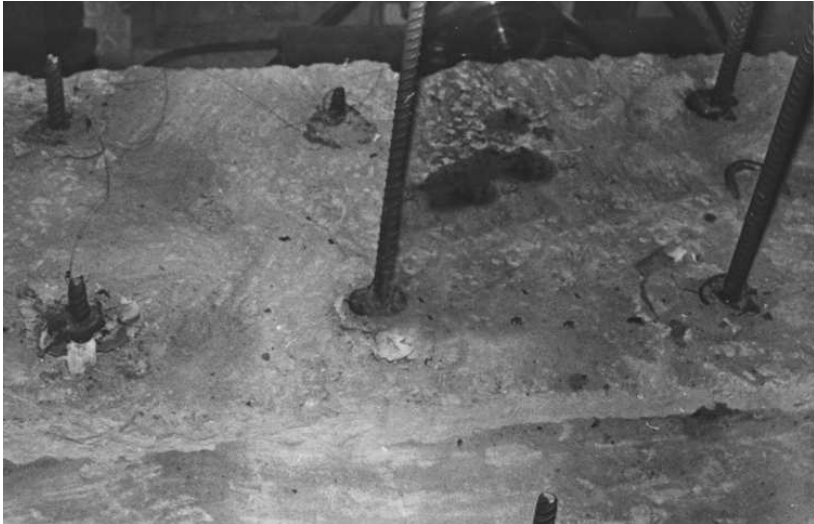
Рис.2 – Характер разрушения клеевой анкеровки арматурных стержней класса А500С при заделке их в бетон акриловыми клеями на глубину l_{анк} = 17,5d_s и 22,5d_s
