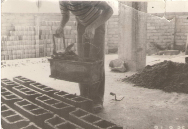
Рис. 4 – Изготовление пустотных блоков
