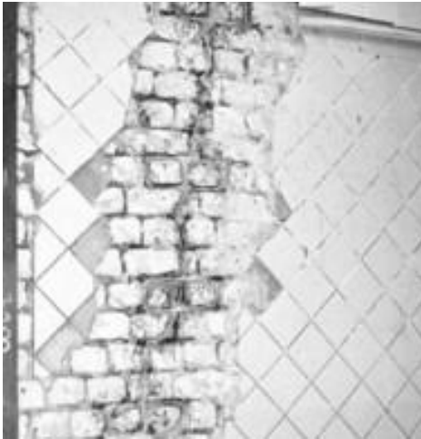
Рис. 5 – Усиленная обмоткой стеклоровингом, пропитанным полимерной композицией холодного отверждения, кирпичная стена с вертикальной трещиной в здании по ул. Полтавский шлях, 148/1
