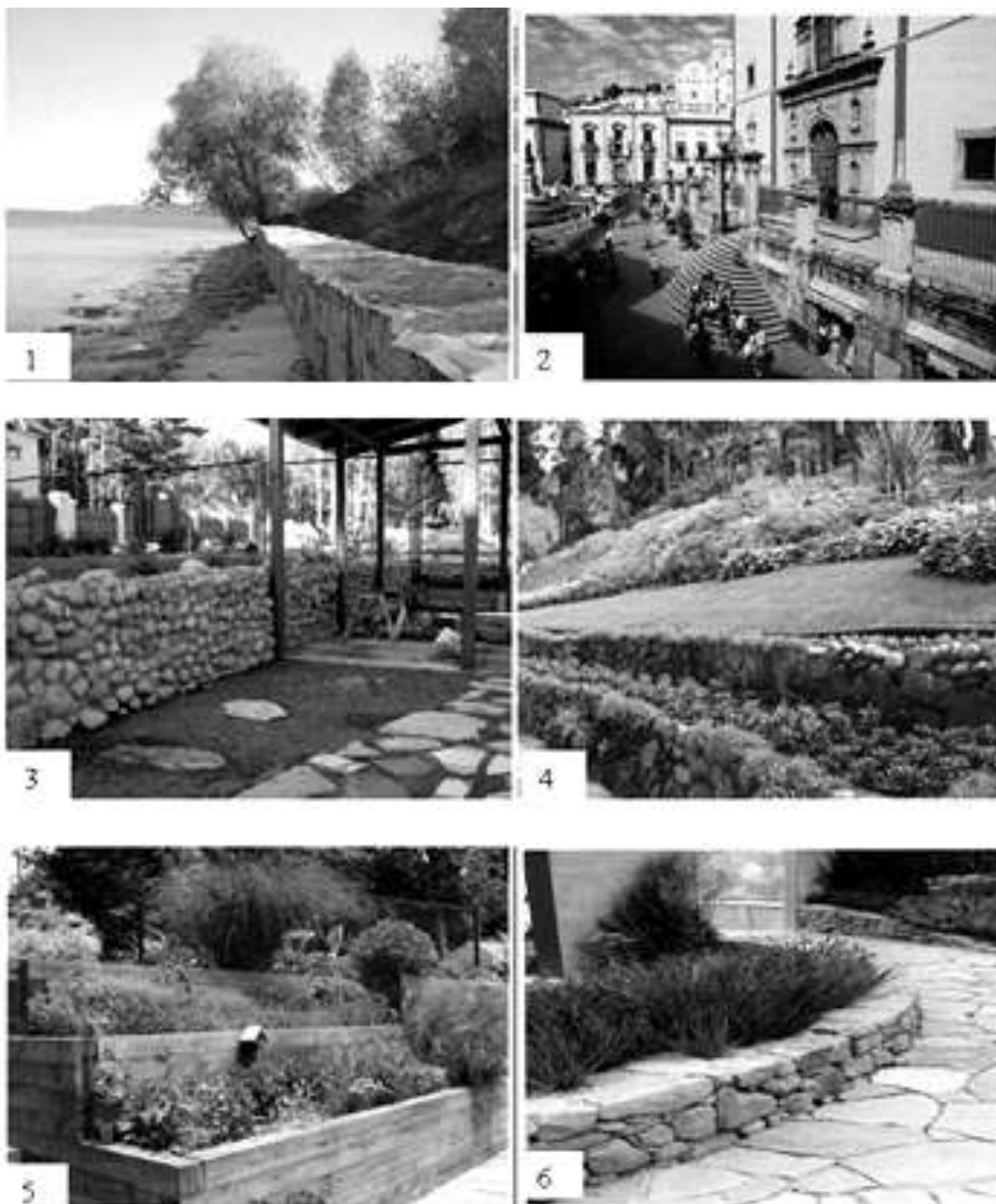
Рис. 4.31 – Приклади улаштування підпірних стін: 1 - 3 – інженерні підпірні стіни (1 – укріплення берегів; 2 – забудова терасами; 3 – планувальне рішення території); 4 - 6 – декоративні підпірні стіни
