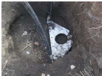
Рис. 4. Затягивание горизонтального коллектора в массив грунта
