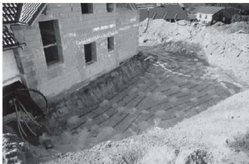
Рис. 2. Укладка горизонтального коллектора в котлован
