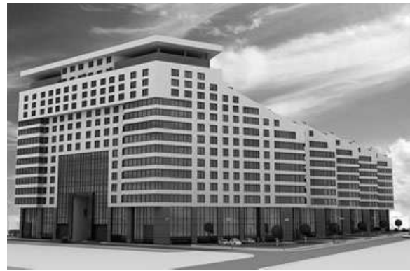
Рис. 9 - Житловий комплекс «Смоленська Застава» - це сучасний 9-секційний комплекс змінної поверховості (від 11 до 16 поверхів) з дворівневою підземною стоянкою і автомийкою, розташований за адресою: провулок Рушничний, буд.3. У будинку 250 квартир площею від 59 до 326 кв. м, висота стель у квартирах становить 3,10 м. На кожній сходовій площадці розташовується від 2 до 4 квартир вільного планування. Вікна 70% квартир комплексу виходять на околиці Плющисі і Садового кільця. У будинку розташований дитячий садок. У внутрішньому дворі будинку - просторий сквер і дитячий ігровий майданчик. На останніх поверхах житлових секцій влаштовані фешенебельні пентхауси з панорамним видом на Кремль та історичний центр Москви.
