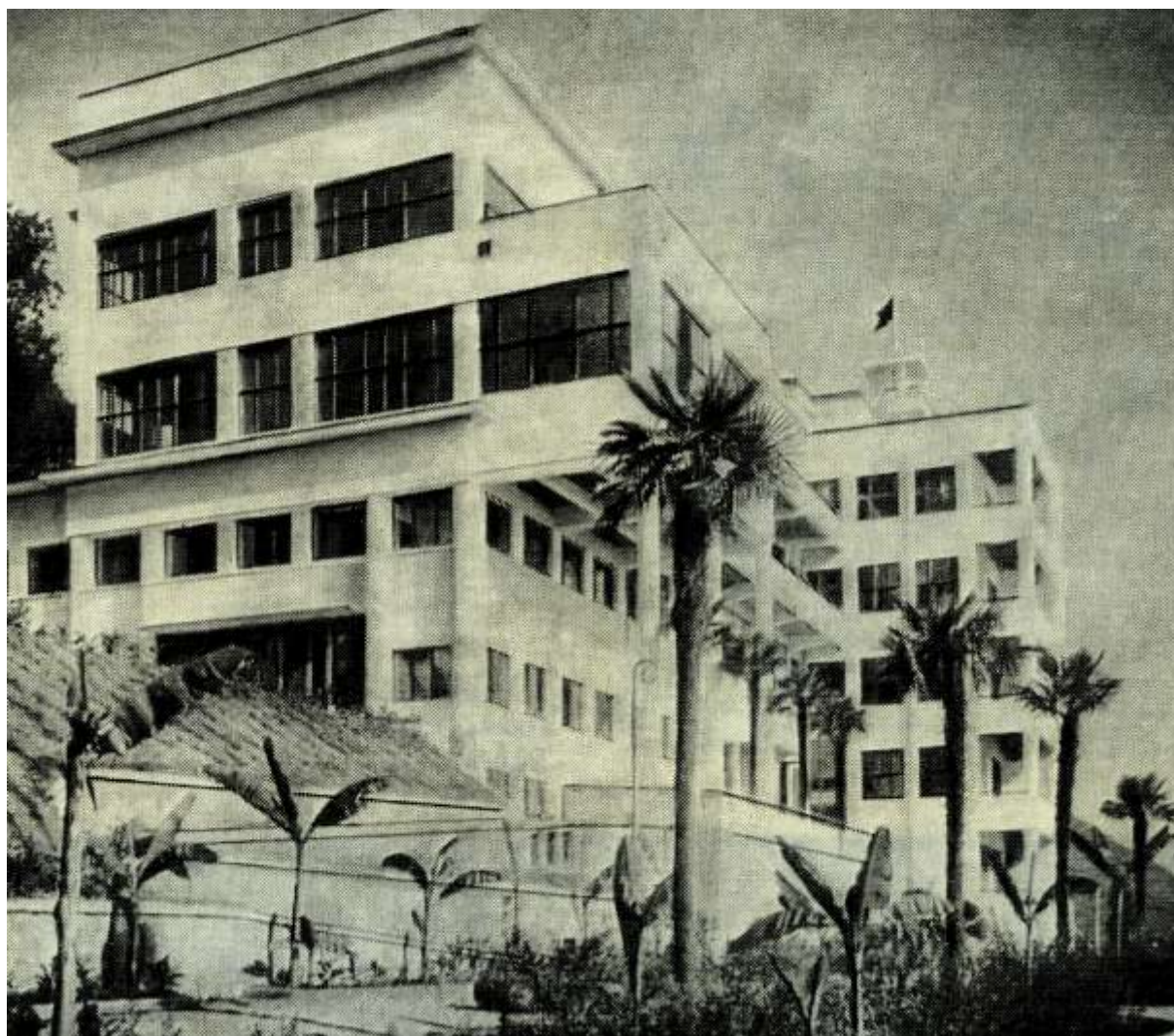
Центральный корпус санатория „Украина” в г. Гагра. Планировка и архитектурное оформление парка выполнены А. И. Колесниковым.
