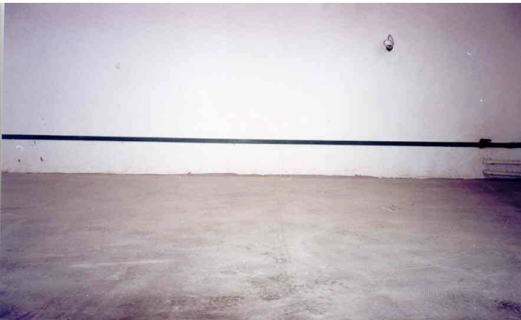
Рис.2 – Общий вид акрилового покрытия пола, уложенного в цехе
