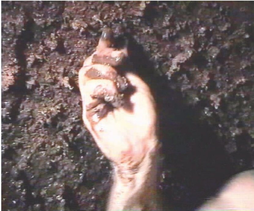
Рис. 3.10. Пальпация макрошероховатости с анаэробными бактериями
