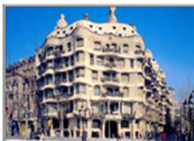
Ла Педрера Арх. Антонио Гауди В эти годы происходит становление научного диалектического материалистического подхода к теории и практике архитектуры
